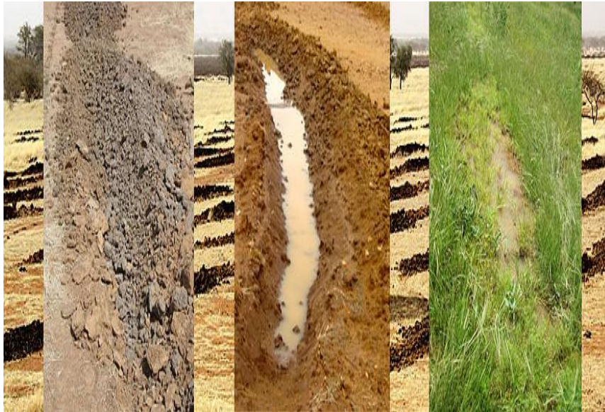
In de Sahelregio graaft Ondernemers Zonder Grenzen sleuven voor watertoevoer met de speciale Delphino ploeg, ca. 7000 per ha.. Foto inzet: details van de maanvormige voren en hun vergroening (2015).
