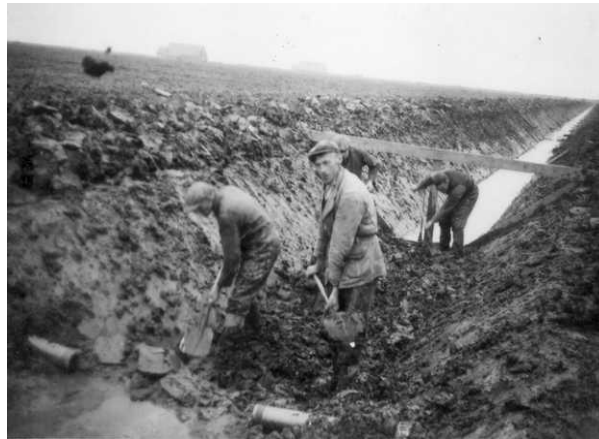
Polderwerkers graven sloten voor waterafvoer bij de ontginning van de Noordoostpolder in 1942.
